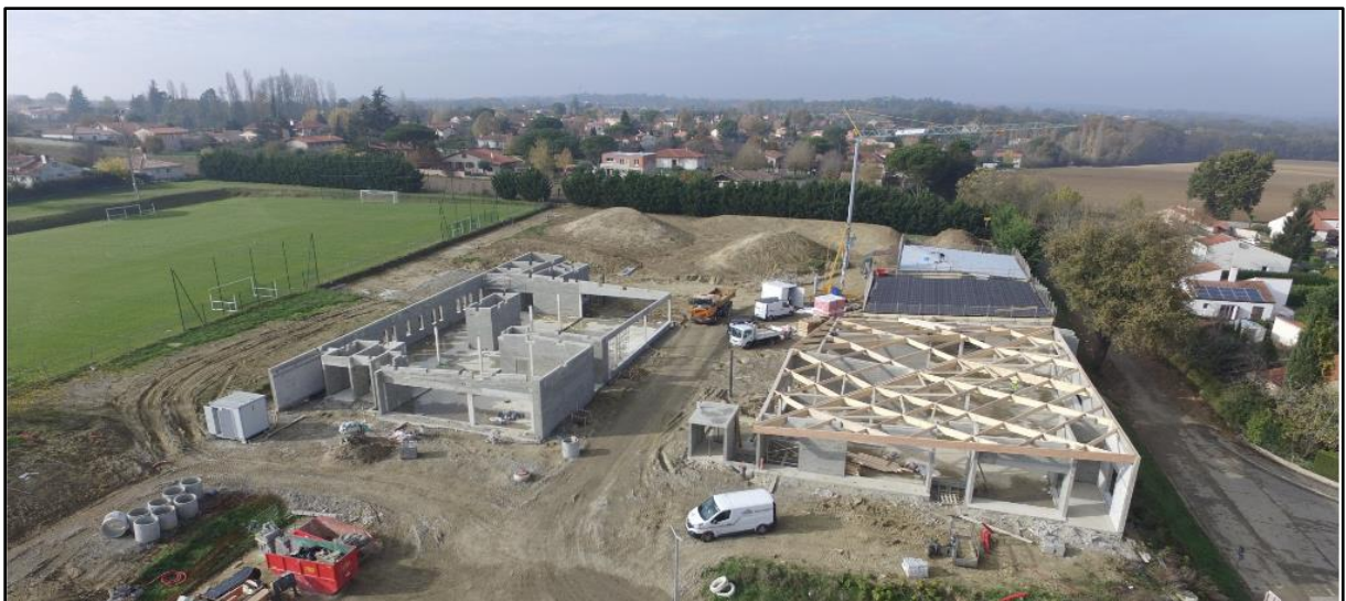
Travaux de construction de l'école maternelle
