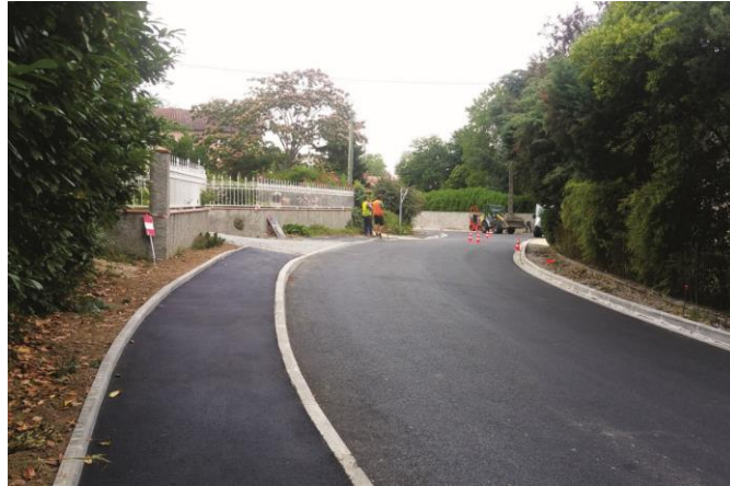
Sécurisation route du Cammas- 2019
