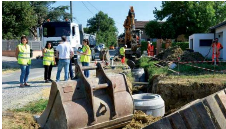
Réunion de chantier – Urbanisation de la route de Moutou
