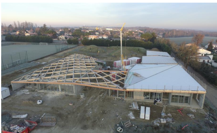
Construction de l'école maternelle – décembre 2018
